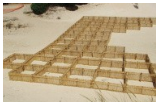
Struttura di canne posizionata ai piedi del sistema dunale del sito di Porto Campana secondo uno schema.
