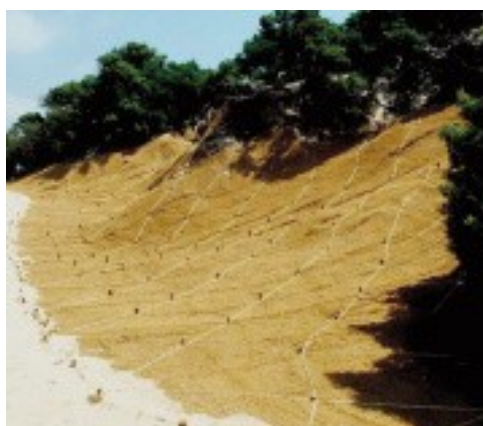
Cagliari - recente intervento sul sistema dunale del SIC di Porto Campana per bloccarne l'erosione
